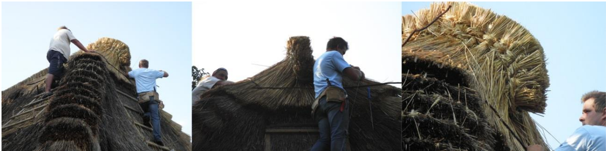
19. ábra – Fonott gerinc, készítés közben (saját fényképek)
