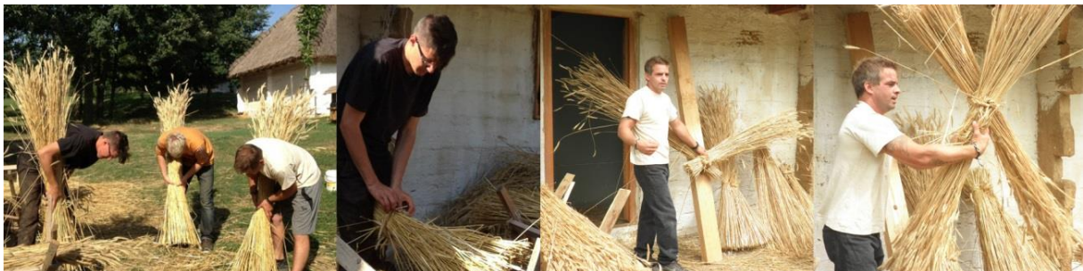
18. ábra – Kévék készítése (saját fényképek)
