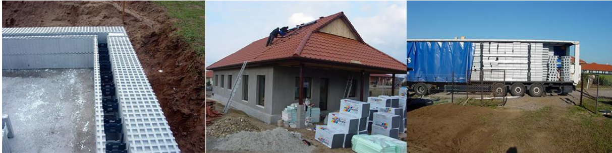
13. ábra - Az épülő szadai passzívház (Balogh György képei)
